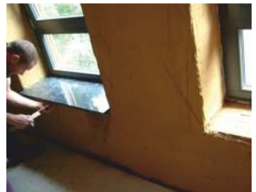
Bild: Wandbekleidung mit Lehmbauplatten
