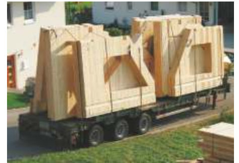
Bild: Anlieferung der Wandelemente
