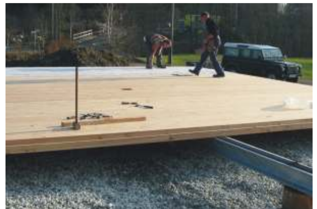
Bild: Profil-Holz-Elemente als Bodenplatte
