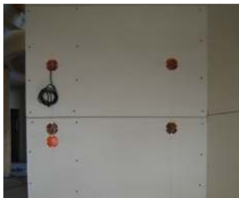
Bild: Wandbekleidung mit Gipsbauplatten
